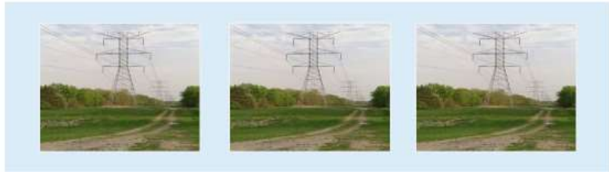
3 - 345 kV Double Circuits
